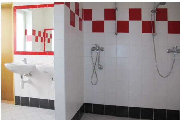
Rekonstrukce sprch v šatnách u velké tělocvičny
