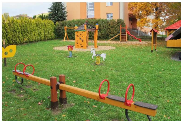
Rekonstrukce a modernizace vybavení zahrady školní družiny
